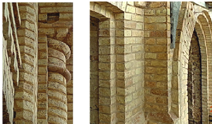
Рис. 5. Фрагменты восстановленных оконных проёмов боковых ризалитов
