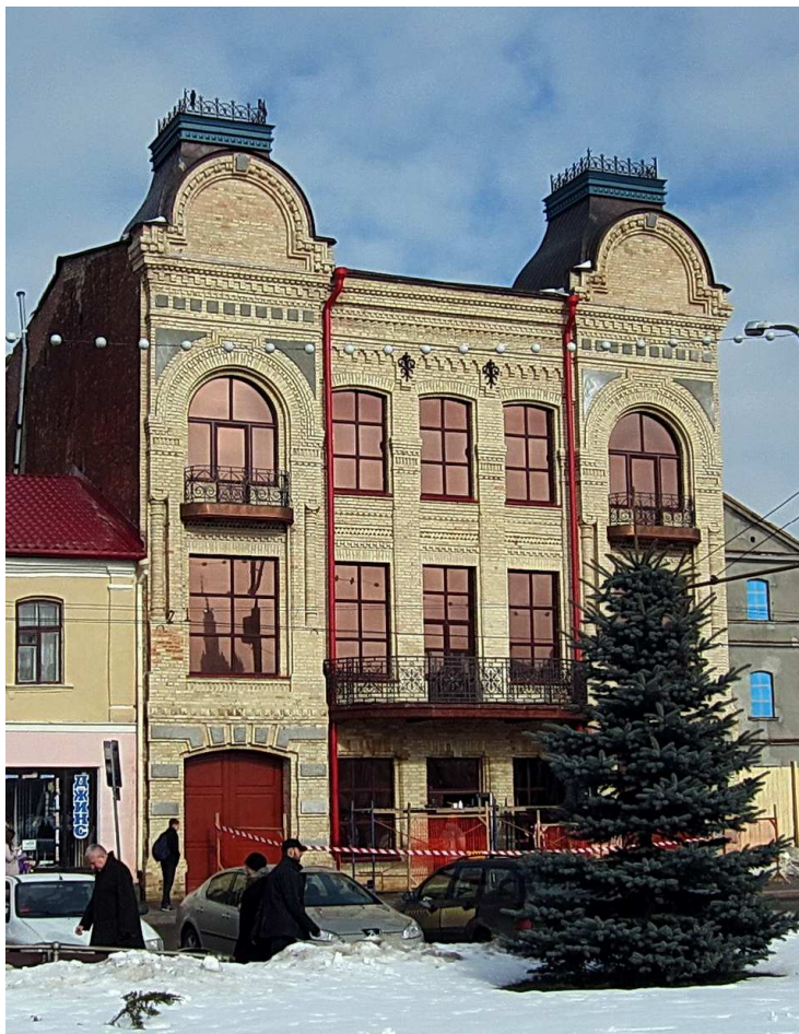
Рис. 3. Дом купца Муравьева в Гродно после ремонта (2013 г.).
