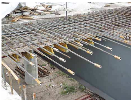
Рис. 2. Общий вид стыкования арматурных стержней
