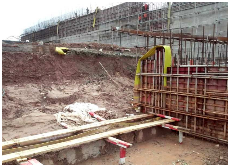
Рис. 1. Противофильтрационная стенка и прилегающая территория
