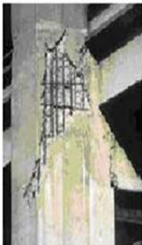
Рис.1. Соединения внахлестку переносят нагрузку на бетон и по мере разрушения защитного слоя бетона выходят из строя
