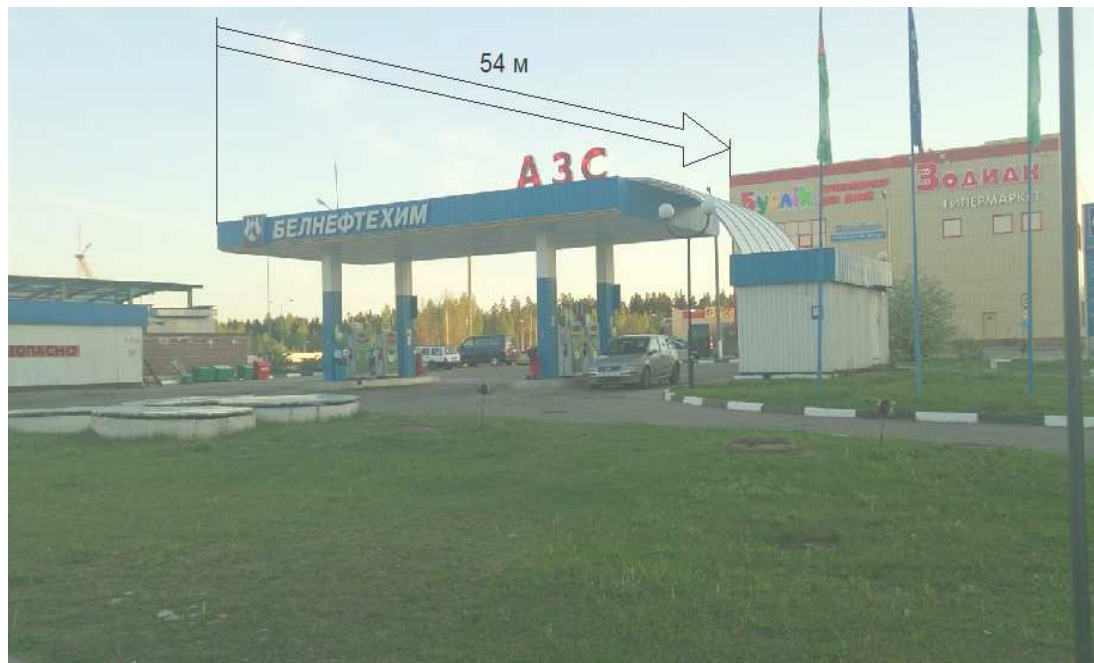
Рис. 1. АЗС «Белнефтехим» возле торгового центра «Зодиак» (расстояние до ТЦ – 54 м)
