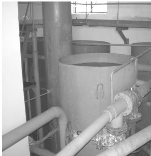
Рисунок 9 – Общий вид станции
