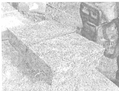
Рис. 4. Распил бензопилой плиты в поперечном направлении
