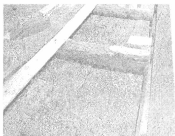
Рис. 5. Костросоломенные плиты на чердачном перекрытии
