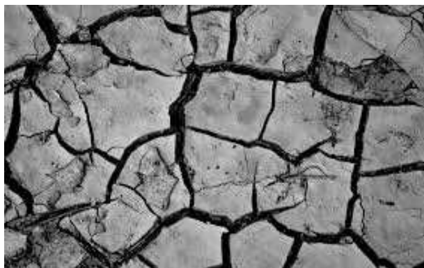
Рис. 4. Выход на поверхность трещин
