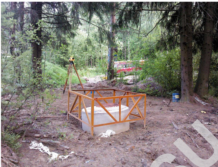
Рис. 4. Новый заложенный фундаментальный репер. Внешний вид
