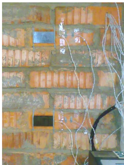
Рисунок 10. – Расположение термопар и датчиков тепловых потоков на наружной стене со стороны помещения
