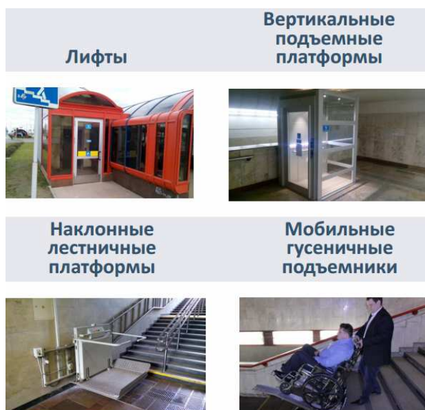
Рис. 1. Техническое оснащение минского метрополитена
