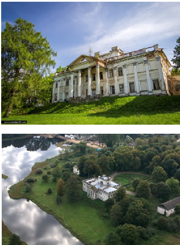
Рис. 3. Современное состояние усадьбы
