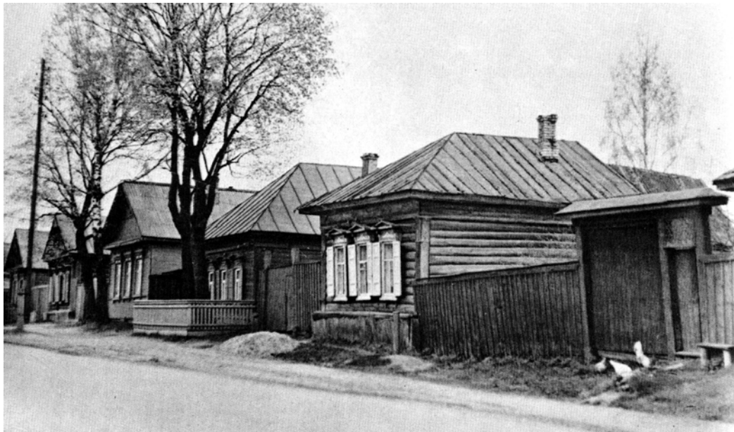
Рис. 1.9. Жилая застройка в Ветке Гомельской области (срубные конструкции)
