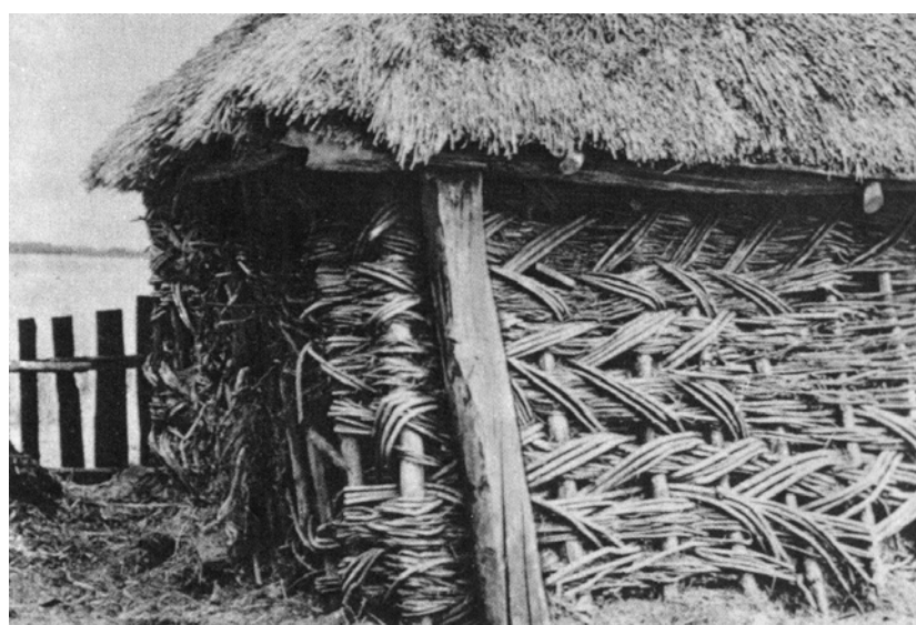
Рис. 1.8. Хлев в Колыбани Брагинского района (столбчатые конструкции)
