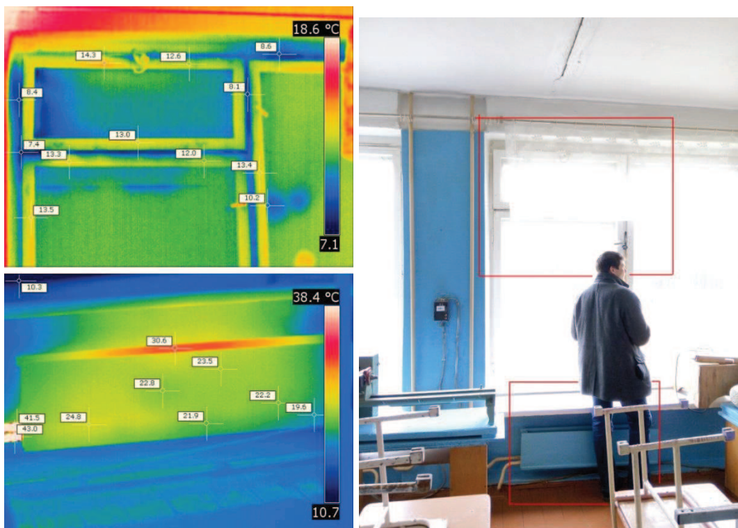
Рисунок 32 – Стена помещения №115 (мастерская по дереву), северный фасад
