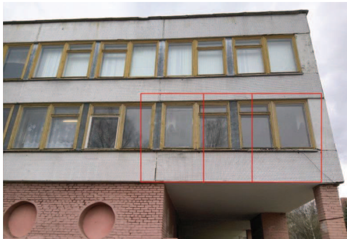
Рисунок 9 – Стена помещения №214 (учебный класс), северный фасад
