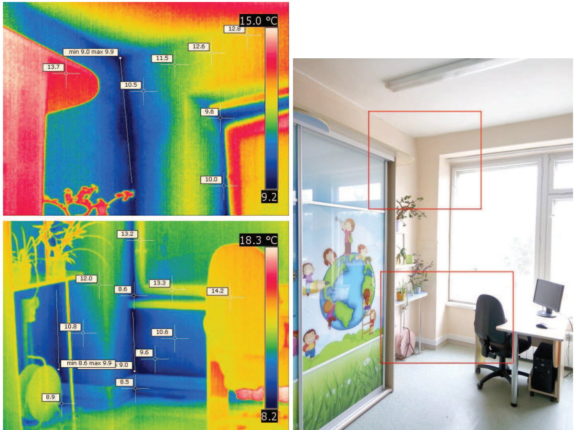
Рисунок 26 – Стена помещения №312 (компьютерный класс), северный фасад
