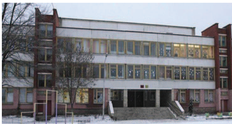
Рисунок 2.1 – Здание БШ № 10 г.Новополоцка
