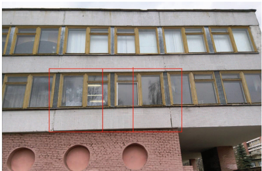
Рисунок 8 – Стена помещения №214 (учебный класс), северный фасад
