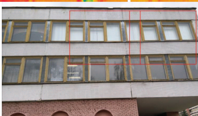
Рисунок 29 – Стена помещения №312, северный фасад
