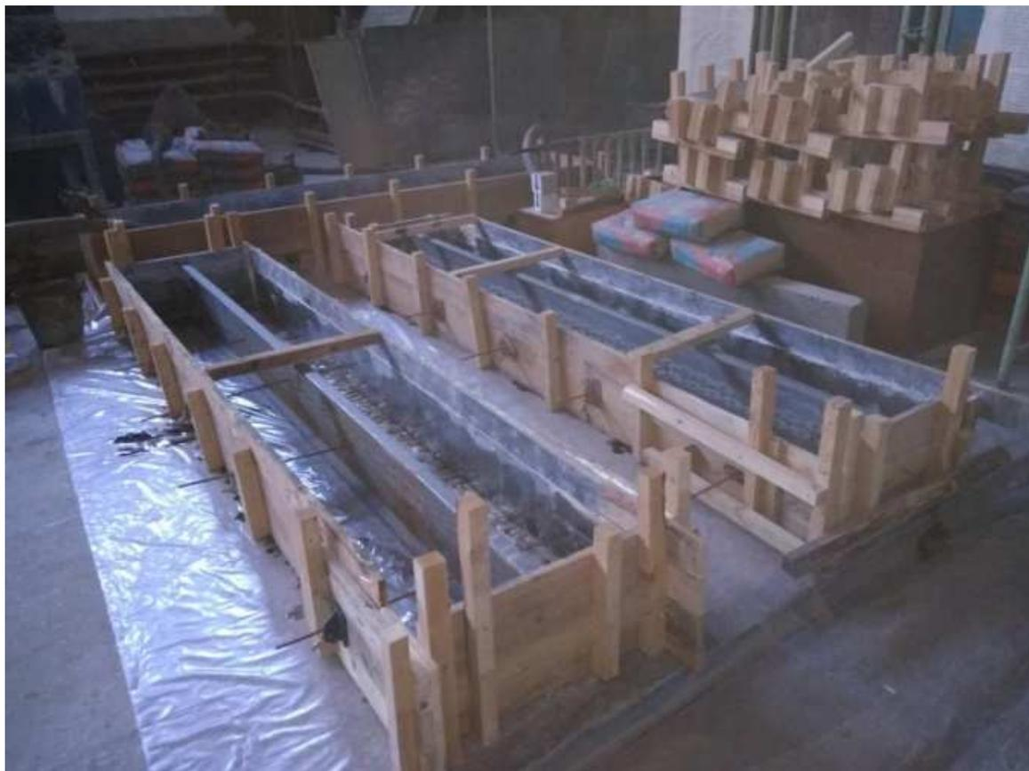
Рис. 2.4 Опалубка с установленным в проектном положении С-образным профилем
