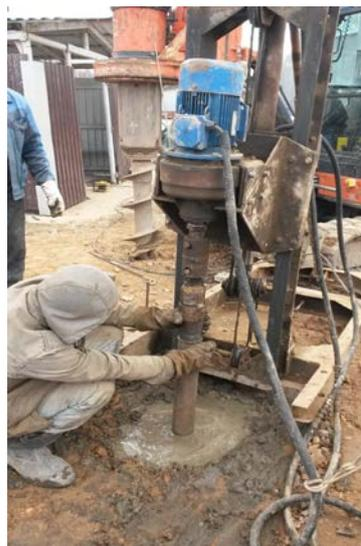
*б***Рисунок 1. – Последовательность устройства свай:*****а* – бурение скважины полым шнеком и заполнение скважины жидким цементным раствором;*****б* – погружение винтовой сваи**
