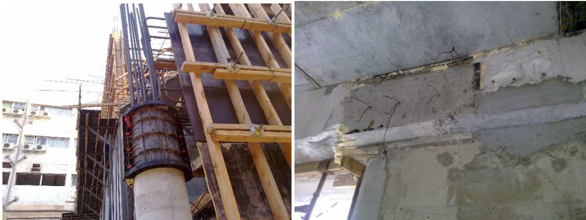
Рисунок 8. – Недостаточная длина арматуры. Плохая очистка и подготовка бетонных поверхностей в области рабочего шва
