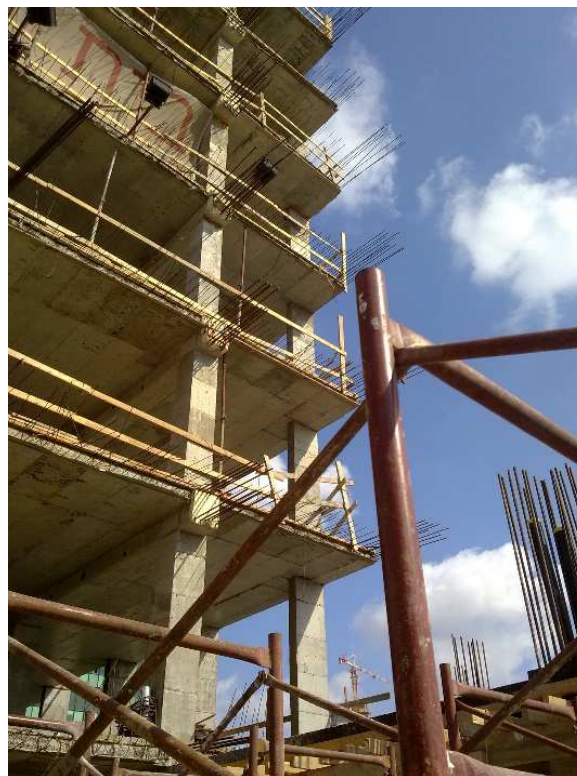
Рисунок 7. – Рабочий шов в железобетонных перекрытиях
