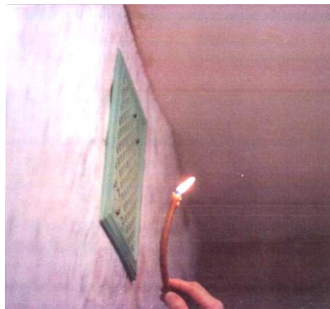
Рисунок 2. – Фиксация «опрокидывания» циркуляции в жилых зданиях
