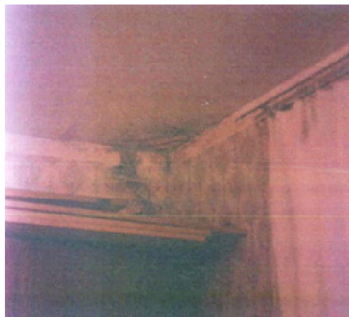
Рисунок 5. – Фиксация плесени у наружных стен
