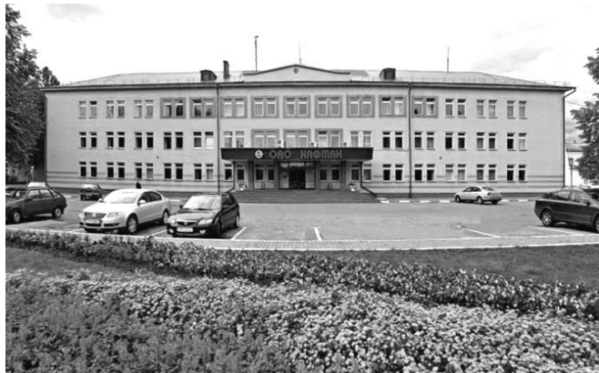
Рис. 3. Здание заводоуправления ОАО «Нафтан»
