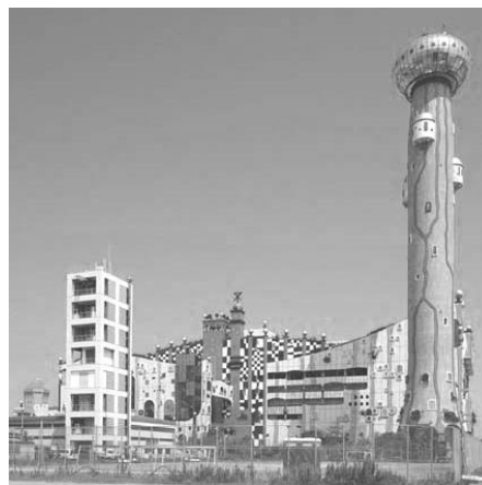
Рис. 7. Завод сжигания осадка сточных вод в Осаке
