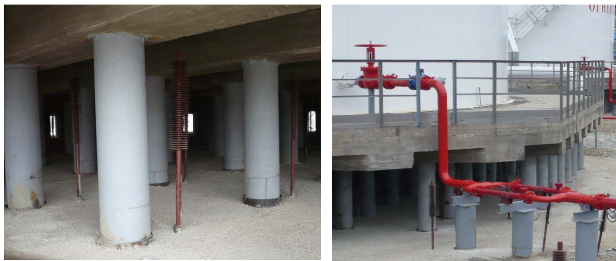
Рис. Применение сезонно-охлаждающих устройств на примере РВС-5000
