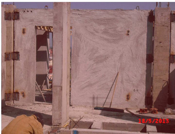
Рис. 2. Крепление сборной панели диафрагмы жёсткости к колоннам
