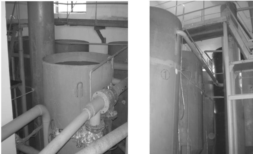
Рис. 6. Пенополистирольные фильтры с технологическими трубопроводами
