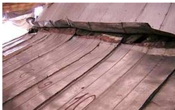
Рис. 2.2. Подготовка к разборке кровельного покрытия из меди
