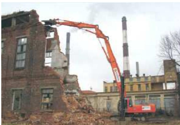
Рис. 2.12. Разрушение кирпичных стен экскаватором, оснащенным гидравлическими ножницами
