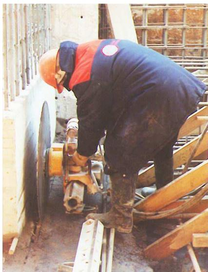
Рис. 2.16. Расширение проема с использованием технологии алмазной резки
