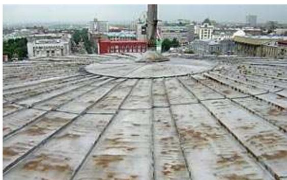
Рис. 2.1. Общий вид купольного покрытия из кровельной стали, поврежденного коррозией
