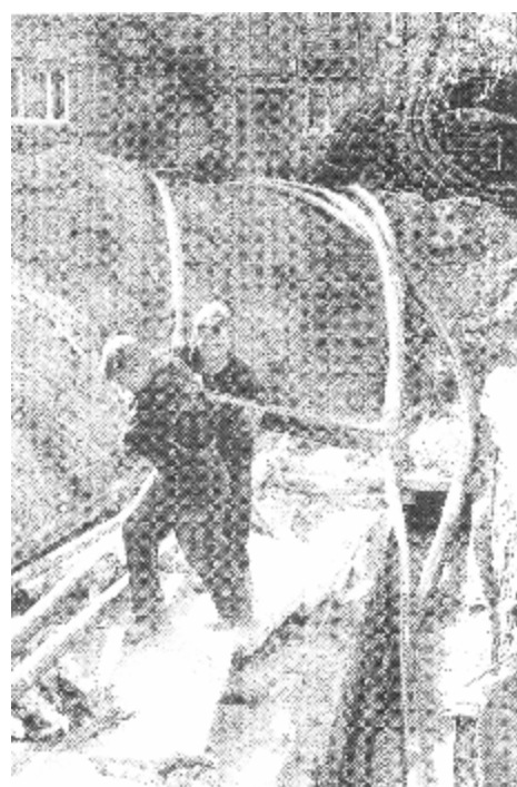
Рис. 4.4. Гибкие теплоизолированные полимерные трубы
