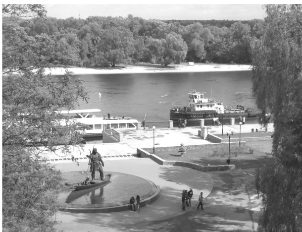
Рис. 4. Набережная реки Сож, Гомель. Современное состояние
