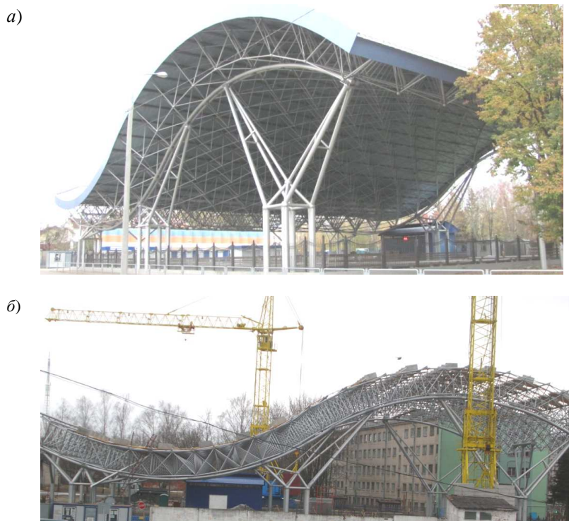
Рис. 3. Покрытие ледового катка в Гомеле: а – общий вид; б – проведение натуральных испытаний
