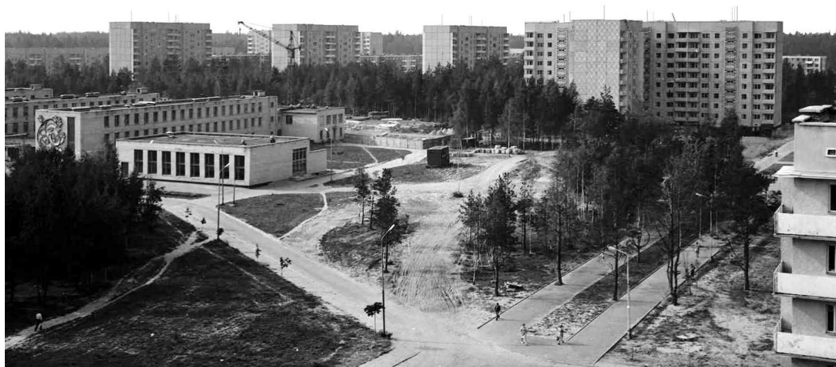
Рис. 26.8. Общий вид лесного массива, сохраненного во время строительства школы № 4 в Новополюцке
