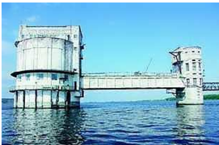
Рис. 3.4. Водозабор островного типа
