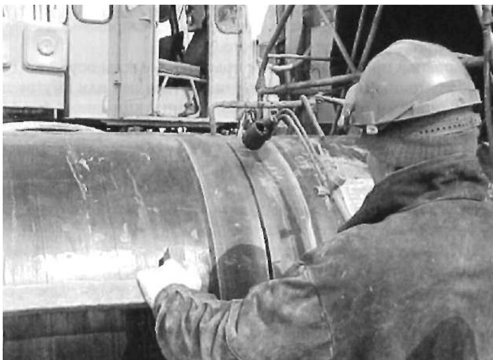
Рисунок 5.4 – Сушка кромок пропановой горелкой
