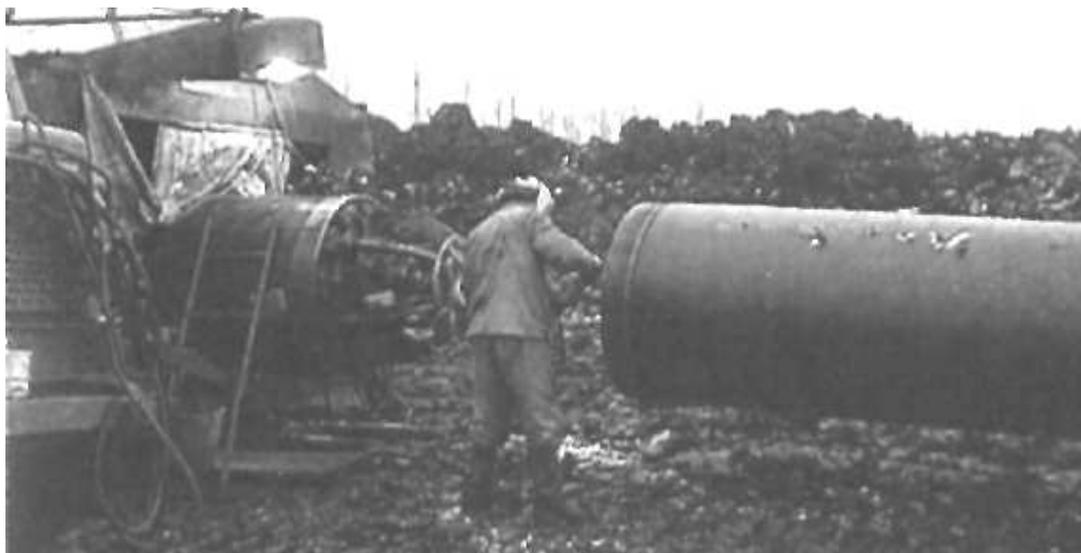
Рисунок 5.3 – Подготовка торцов труб и монтаж трубной секции
