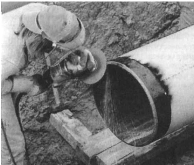
Рисунок 5.1 – Подготовка торцов труб к сварке
