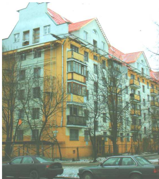
Рис. 7.21. Мансарда жилого дома в г. Минске
