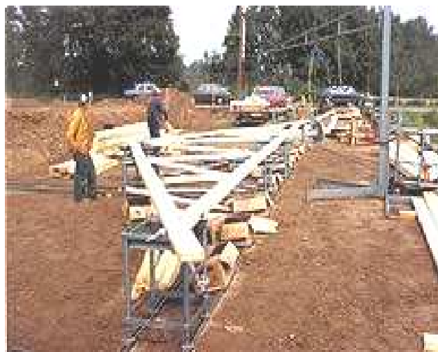
Рис. 7.16. Сборка деревянной фермы на МЗП на строительной площадке
