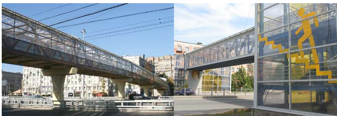
Рис. 2. Надземные пешеходные переходы, г. Москва
