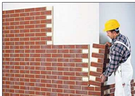
Рис. 2. Облицовка здания термопанелями
