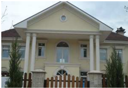
Рис. 2. Здание с фасадом, выполненным при помощи декоративной штукатурки
