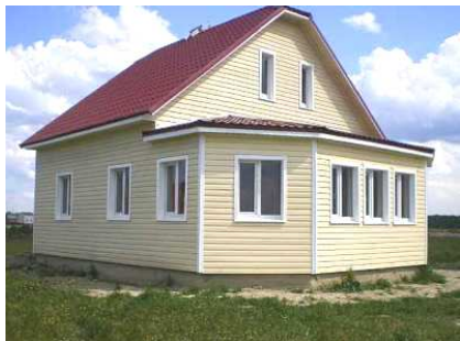
Рис. 3. Здание с облицовкой из винилового сайдинга
