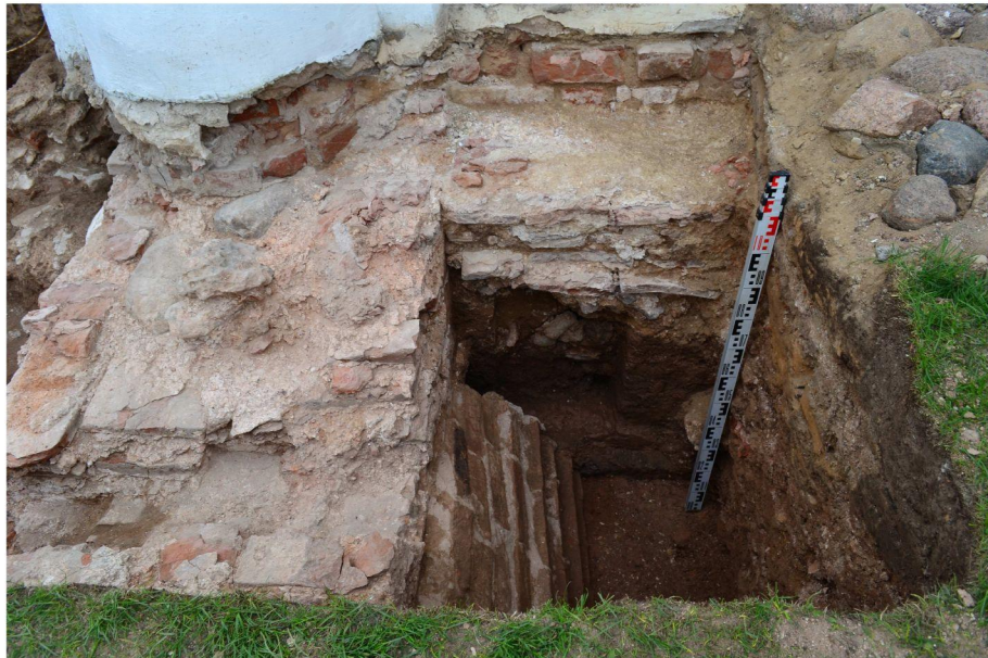
Рис. 5. Шурф 1 (у северо-западного угла храма). Кладка из плинфы в основании западного фасада (укрепление стены нартекса)
