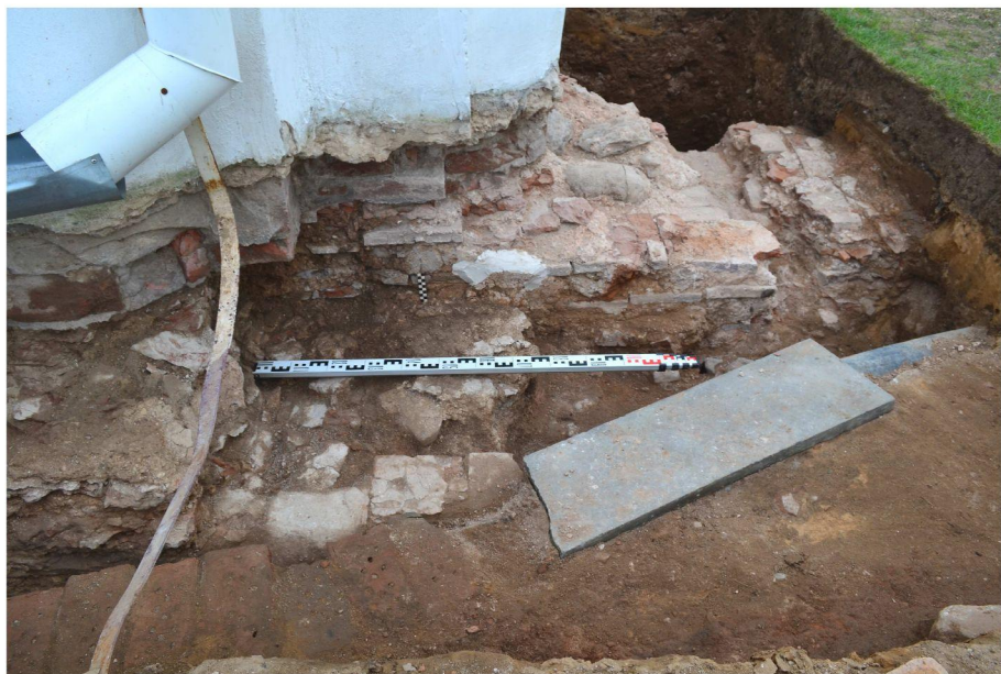
Рис. 4. Шурф 1 (у северо-западного угла храма). Примыкание западной части галереи к основному объему храма
