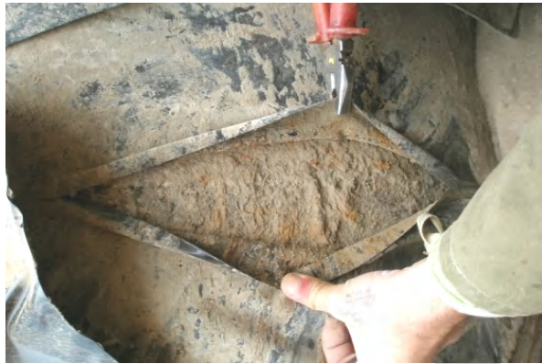
Рис. 1. Пример отслоения изоляционного покрытия магистрального трубопровода
