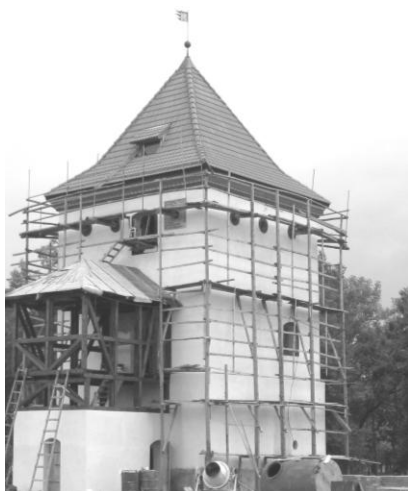
Рис. 12. Южная башня во время восстановительных работ, 2009 г.
