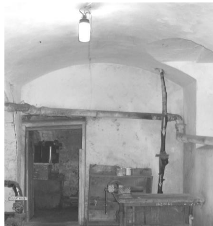
Рис. 23. Подвальное помещение в северо-западной части дворца
