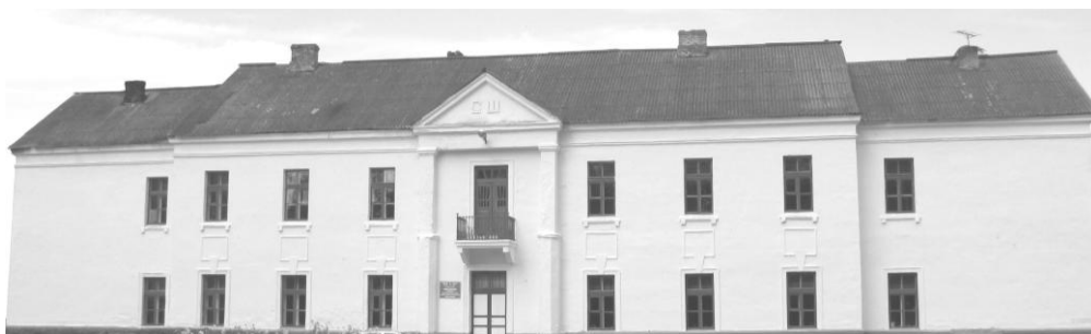
Рис. 20. Учебный корпус (юго-западный фасад, вид с замковой площадки)
