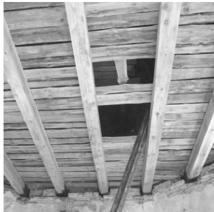
Рис. 6. Восстановленное перекрытие четвертого яруса
