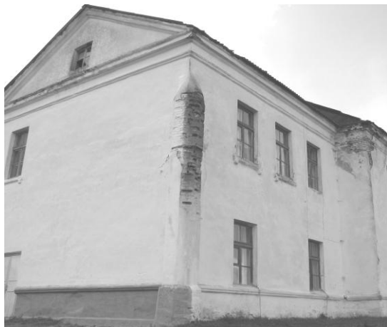
Рис. 22. Сохранившийся фрагмент декоративной башни на пересечении юго-восточного и северо-восточного фасадов
