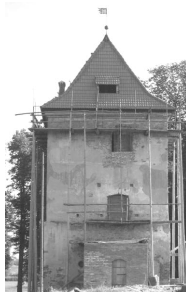
Рис. 9. Южная башня во время восстановительных работ, 2008 год
