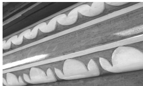
Рис. 11. Фрагмент сграффито на карнизе южной башни
