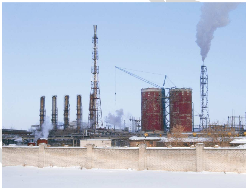
Рисунок 2 – Азототуковый завод Восточного промышленного района
