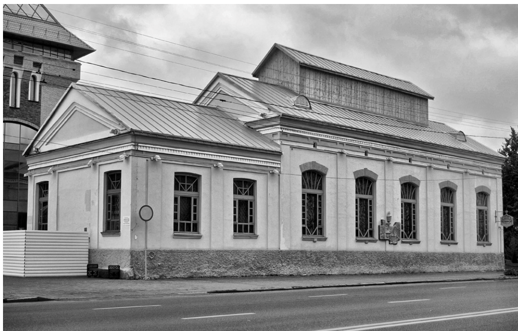
Рисунок 2 – Здание электростанции, 1898 г. Современное состояние
