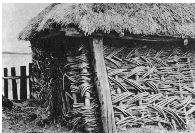
Рис. 1.8. Хлев в Колыбани Брагинского района (столбчатые конструкции)
