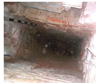
Мал. 6. Заходняя шахта ў тоўшчы сцяны, якая злучае санітарныя вузлы на ўсіх паверхах корпуса «Г»
