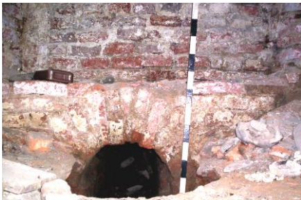
Мал. 4. Акенца для выпуску дрэнажнай трубы ў вонкавай паўднёвай сцяне корпуса «А» пад лесвіцай
