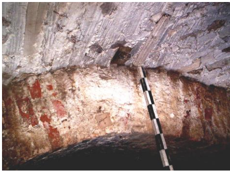
Мал. 3. Скляпенне і падпружная арка з часткова замураванымі дошкамі апалубкі іх адбіткамі на абмазцы
