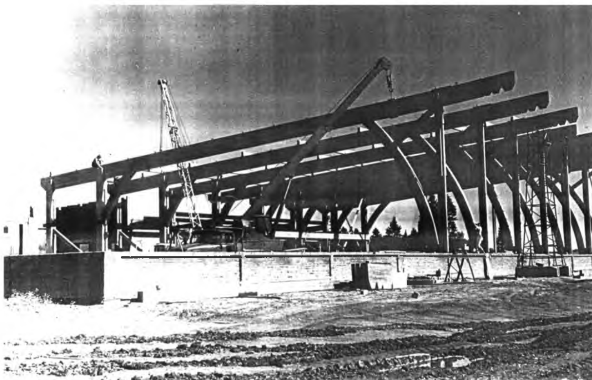
Рис. 1.4. Конноспортивный манеж с рамами из клееной древесины в Шаховском районе Московской области
