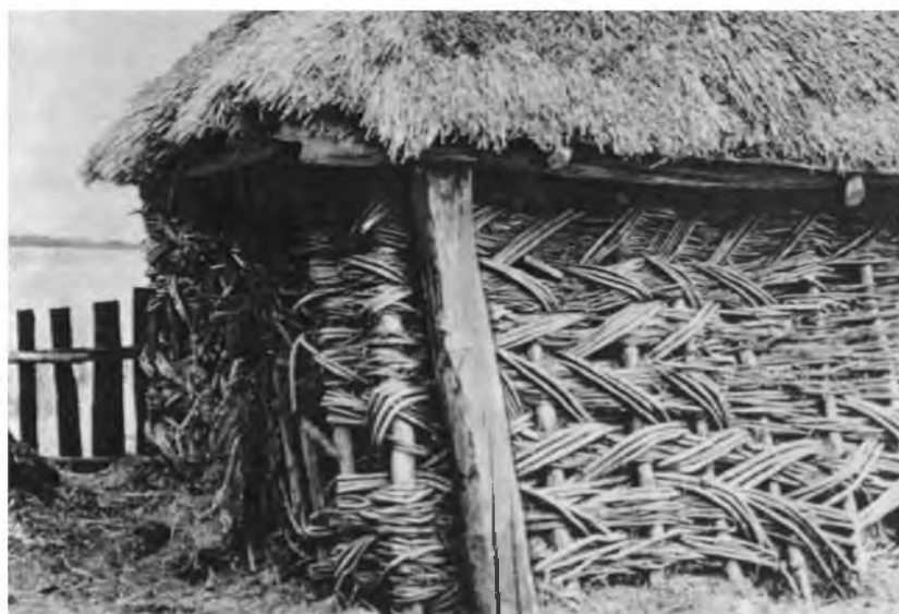
Рис. 1.8. Хлев в Колыбани Брагинского района (столбчатые конструкции)
