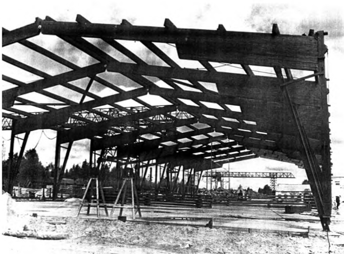
Рис. 1.6. Лесопильный цех в п. Курлово Владимирской области, монтаж рам пролетом 24 м
