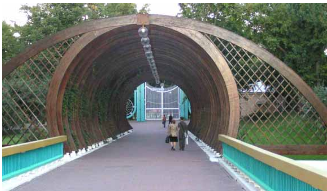
Рис. 1.7. Реконструкция Алексеевского моста – пергола из клееных деревянных арок кругового очертания
