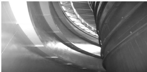
Рис. 2. Межстенное пространство резервуара с защитной стенкой (внешний резервуар усилен ребрами жесткости; внутренний резервуар усилен канатами)
