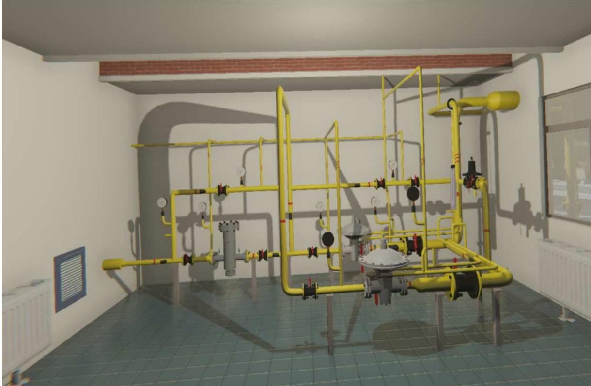
**Рисунок 1. – Общий вид виртуального газорегуляторного пункта**
