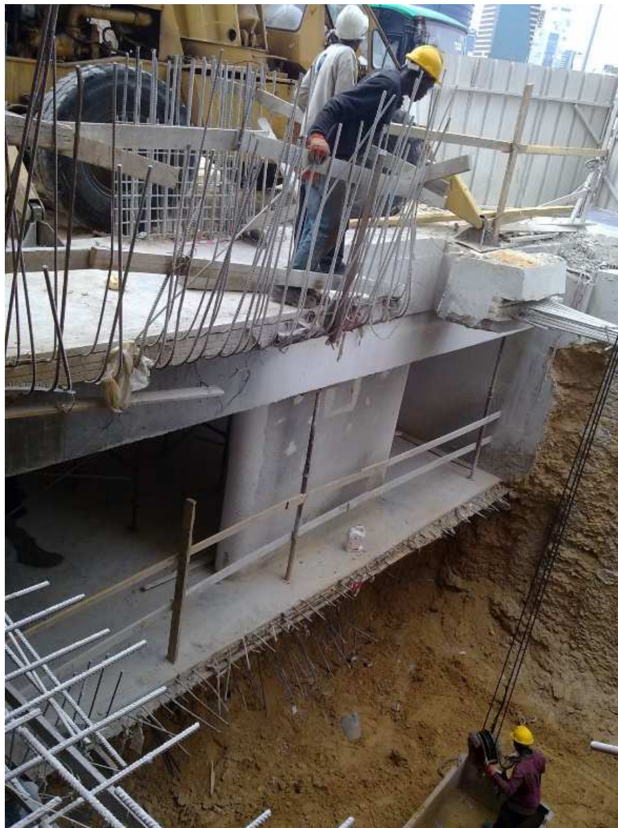
Рисунок 5. – Земляные работы в зоне С. Мобильный кран установлен на рампе. Колонна 4 забетонирована в пределах верхнего этажа подвала, для нижних этажей оставлены выпуски арматуры. На переднем плане – выпуски арматуры перекрытия
