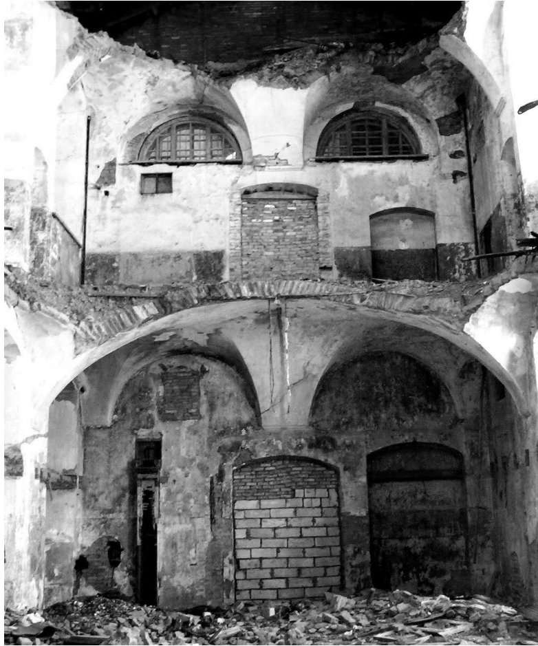
Рисунок 1. – Вид залов трапезной и библиотеки перед восстановлением. На сохранившейся части свода и располагалась реконструируемая нами печь, закрывавшая нишу рядом с замурованным входом
