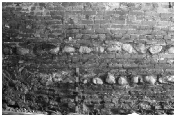
Рисунок 2. – Фундамент северной стены библиотеки и трапезной (корпус «Б»). на уровне нижнего ряда камней видна арка для выпуска дренажа.
