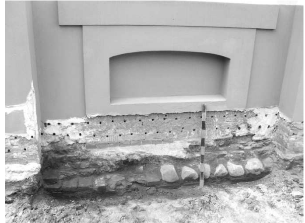
Рисунок 4. – Массивная кирпично-каменная выкладка возле корпуса «Б» под скат отмостки
