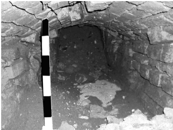
Рисунок 3. – Внутренний вид сохранившегося участка тоннеля, ведущего из туалета корпуса «Г»
