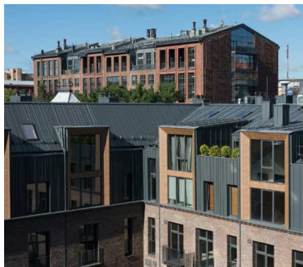
Рисунок 2. – Облицовка фасада здания бывшего завода «Рассвет» кирпичом, г. Москва, Россия (арх. Д. Лоренц, Н. Сидорова, К. Ходнев.)
