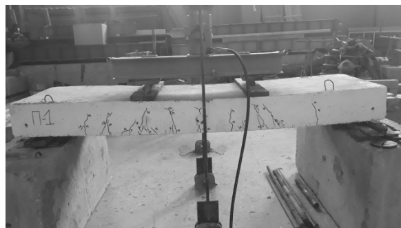
Рисунок 4. – Общий вид плиты П-1 после разрушения
