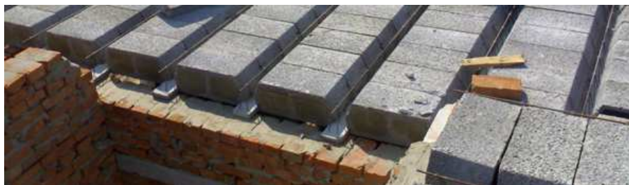
Рисунок 7. – Пример устройства сборно-монолитных перекрытий в Беларуси
