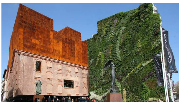
Рисунок 3. – Облицовка фасада здания бывшей электростанции металлическими листами, г. Мадрид, Испания (арх. Ж. Херцог, П. де Мерон)
