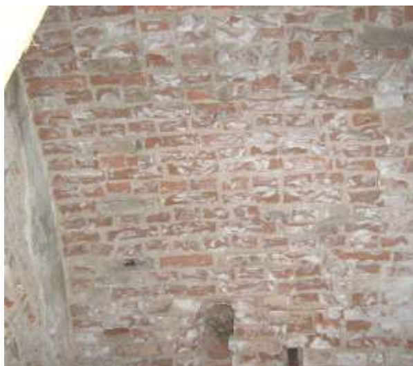
Рис. 12. Разрушение кладки свода 1-го этажа
