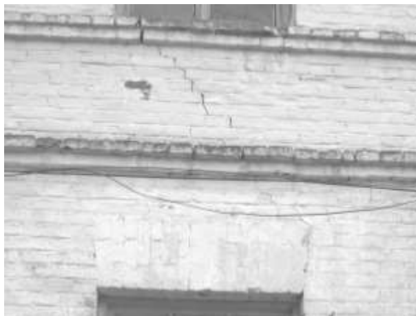
Рис. 15. Сквозная трещина по наружной стене между оконными проемами 1-го и 2-го этажа
