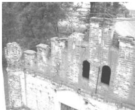
Рис. 14. Разрушение верхних рядов кладки декоративной башни и южного фронтона
