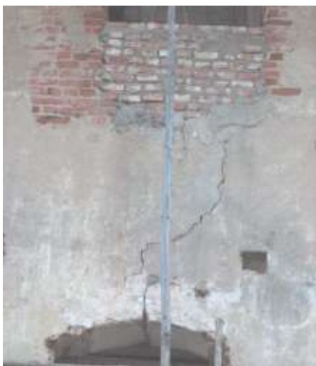
Рис. 11. Сквозная трещина на северной стене между проемами 2-го и 3-го этажа
