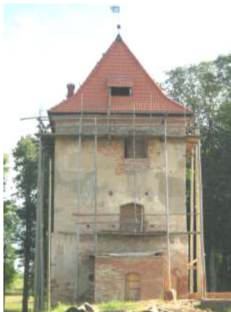
Рис. 10. Южная башня во время восстановительных работ, 2008 год
