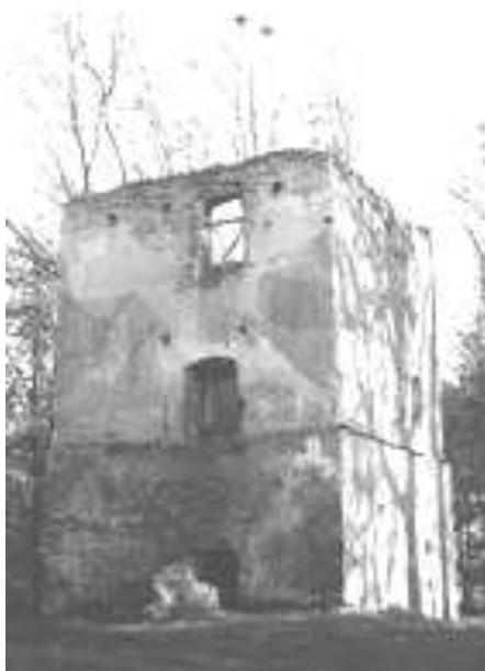
Рис. 9. Южная башня до начала восстановительных работ
