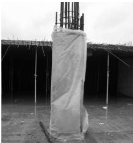
Рис. 1. Уход за бетоном колонны путем укрытия ее полиэтиленовой пленкой
