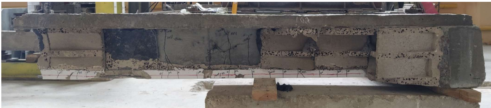
Рисунок 2.10 – Правая часть фрагмента после разрушения (сторона А)
