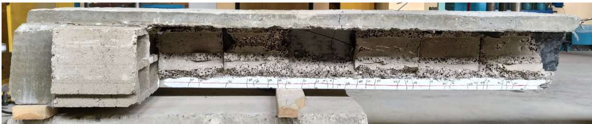
Рисунок 2.11 – Правая часть фрагмента после разрушения (сторона Б)
