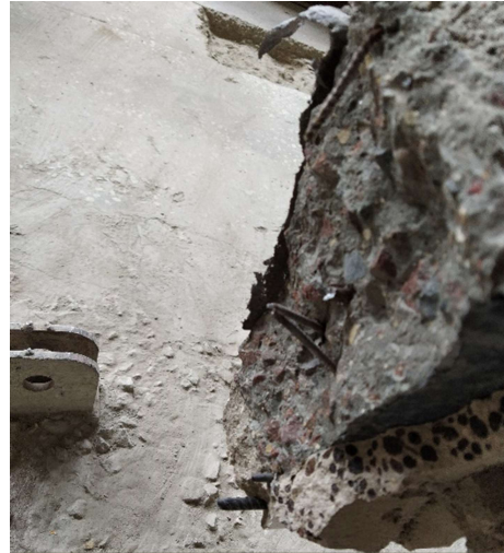
правая часть балки
