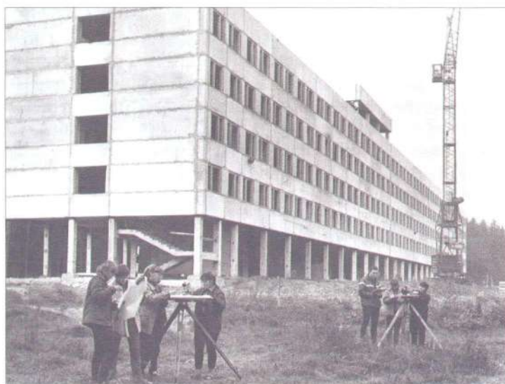
Будівництво вучэбна-лабараторнага корпуса № 3
