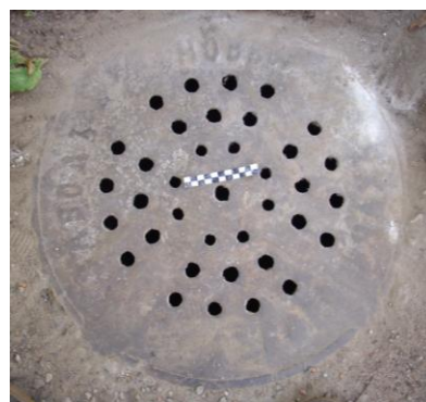
Рис. 4. Крышка дождевого люка для осушения подъездов со стороны ул. Стрелецкой
