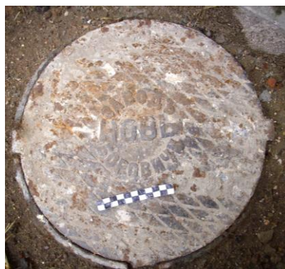
Рис 5. Крышка дождевого люка возле главного входа в корпус Г
