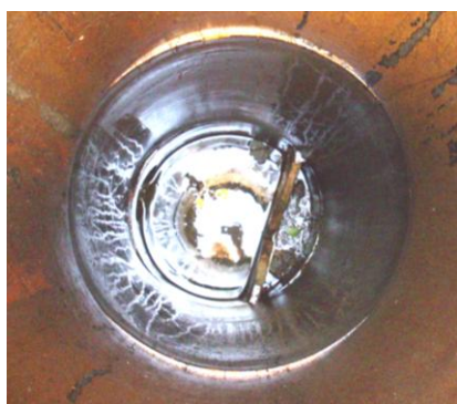
Рис. 9. Конструкция фильтрового колодца начала XX века во дворе корпусов А и Г
