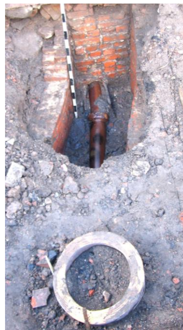
Рис. 10. Керамические трубы и засыпанный смотровой колодец канализации, устроенной на месте кирпичного тоннеля из корпуса В
