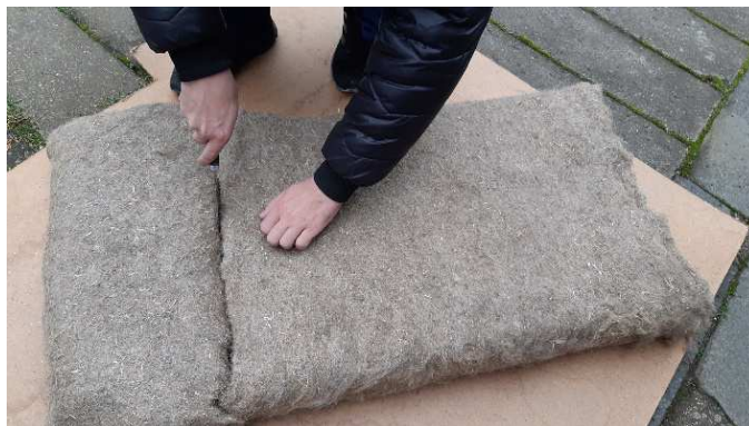
Рисунок 1. – Резка ножом плиты из льняных очёсов
