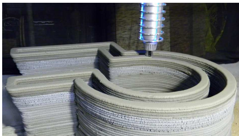
Рисунок 2. – Создание печатного слоя методом послойной печати
